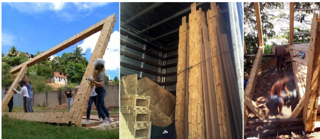
Figura 4. Pré-montagem na fábrica, transporte via caminhão baú e montagem no local, respectivamente.
