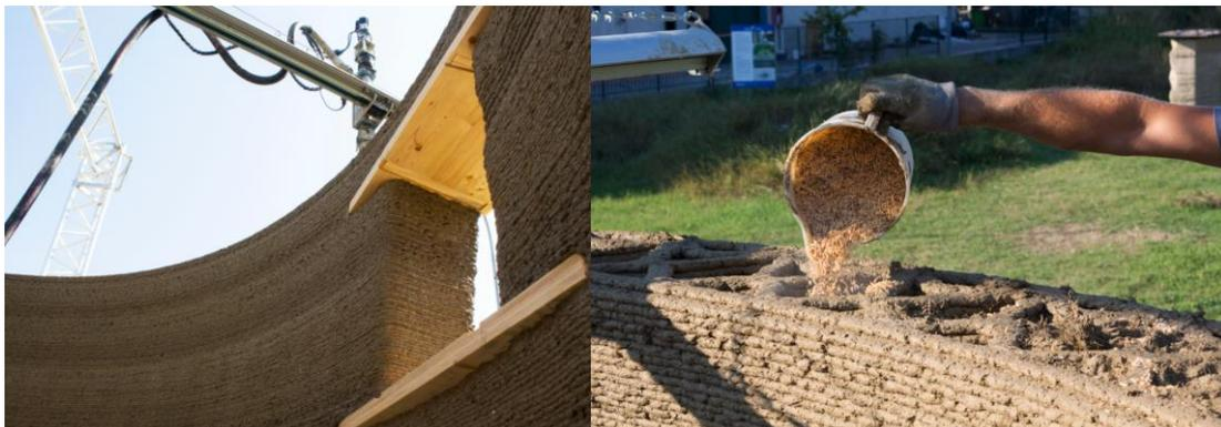
Figura 06. Muro Gaia na sua etapa final (esquerda). Recheio interno do muro (direita). Fonte: WASP
