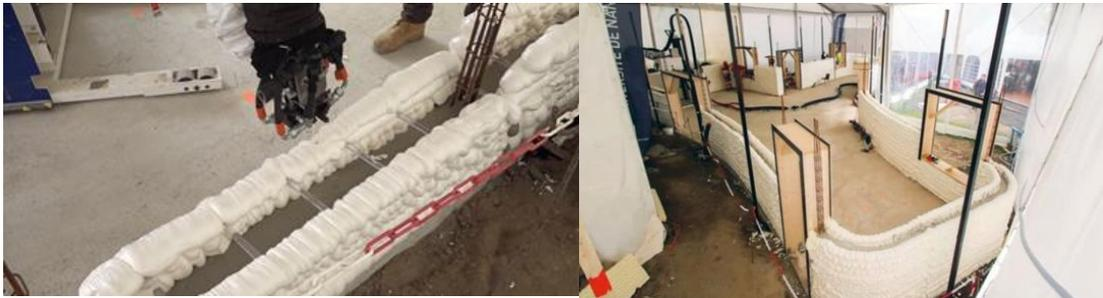
Figura 11. Início do processo de construção da casa Yhnova. Fonte: P. Poullain et al. (2018)
