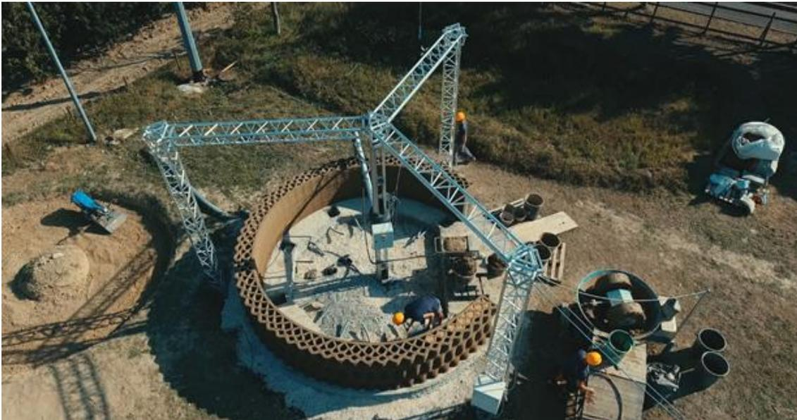
Figura 02: Máquina CraneWASP na produção do primeiro modelo Gaia. Fonte: WASP
